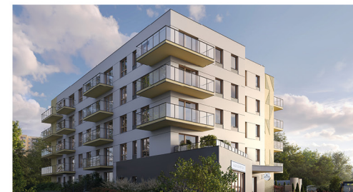
Widok od strony ulicy
