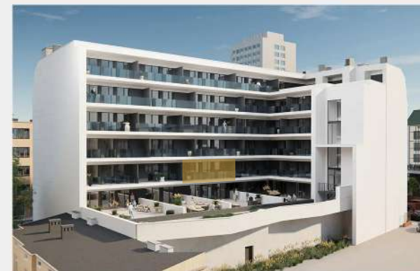
Rzut budynku od strony wewnętrznej
