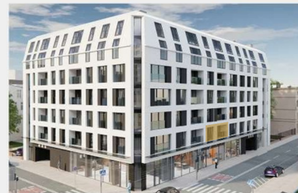
Rzut budynku od ul. Wólczńskiej
