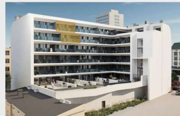
Rzut budynku od strony wewnętrznej
