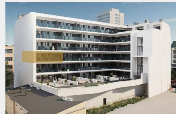
Rzut budynku od strony wewnętrznej
