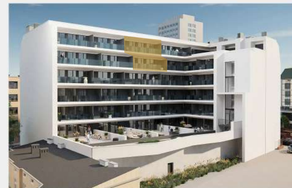
Rzut budynku od strony wewnętrznej
