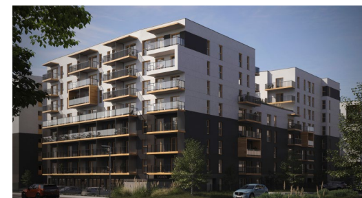
Rondo Ceglana etap II
