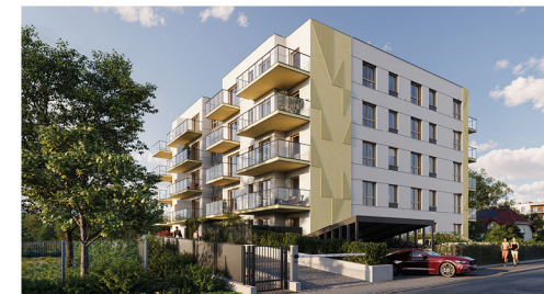
Widok od strony ulicy
