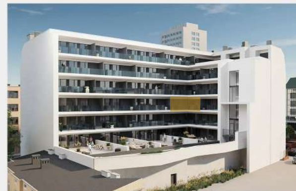
Rzut budynku od strony wewnętrznej
