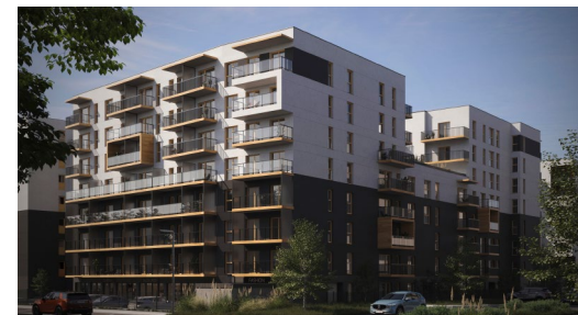
Rondo Ceglana etap II
