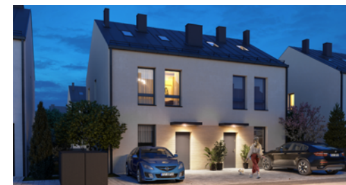
Widok od strony ulicy
