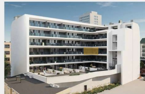
Rzut budynku od strony wewnętrznej
