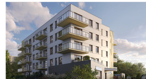
Widok od strony ulicy
