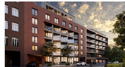
Widok od strony ulicy
