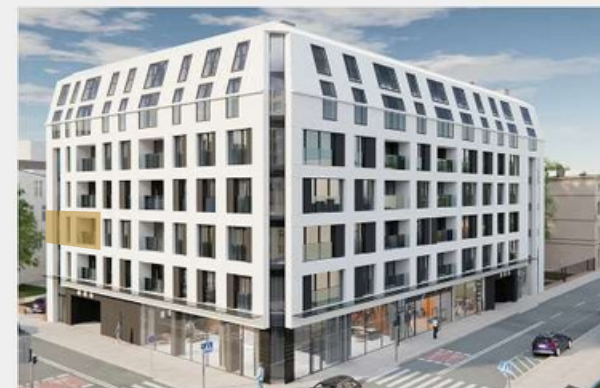
Rzut budynku od ul. Wólczńskiej
