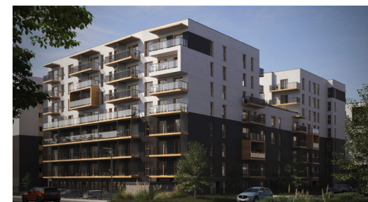
Rondo Ceglana etap II
