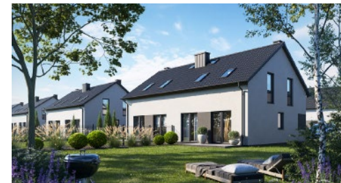
Widok od strony ogrodów
