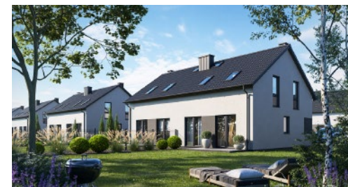
Widok od strony ogrodów
