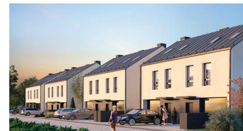
Widok od strony ulicy
