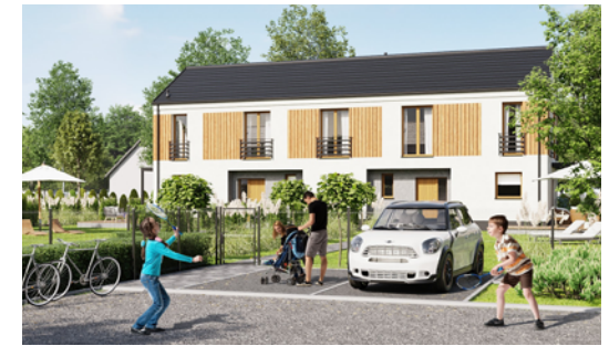
Widok od strony ulicy
