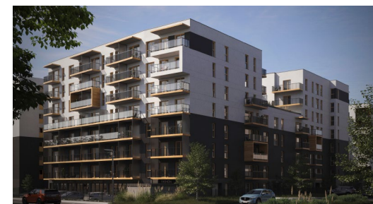
Rondo Ceglana etap II
